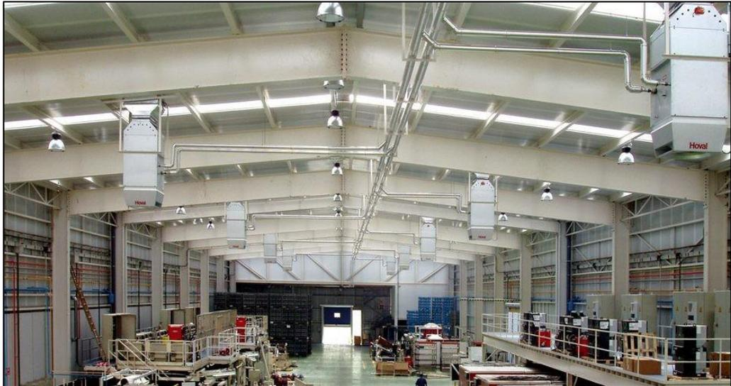
Figura 92. Ventilación por techos
